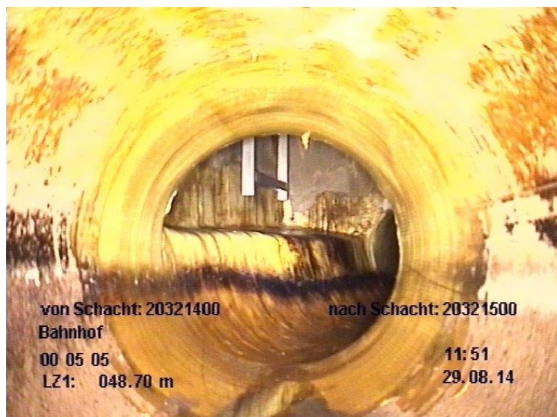
Foto Nr. 4: Inlinerfixierung mit V4A-Sonderkonstruktion und GFK-Laminat
