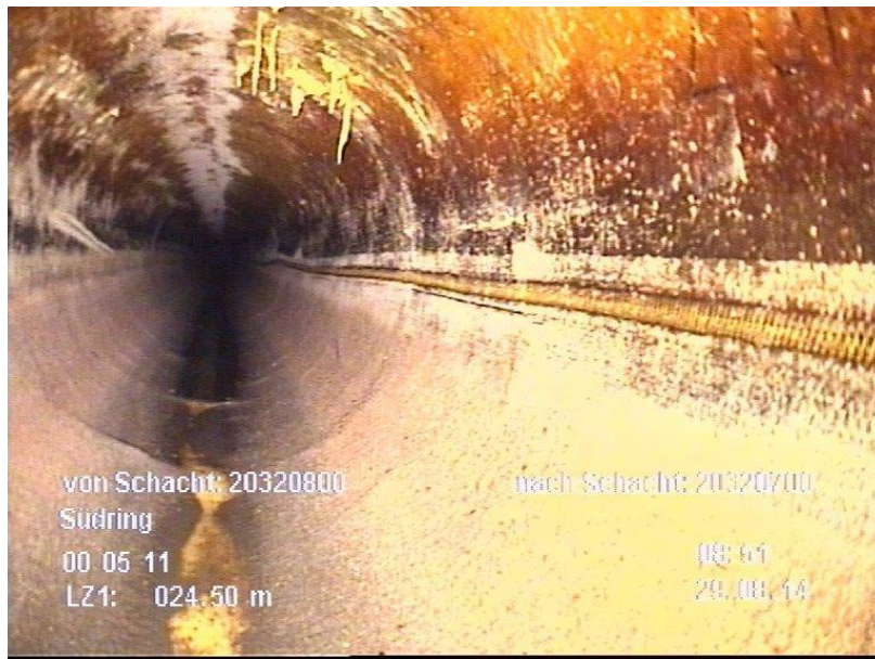
Foto Nr. 5: Inliner im Industriebereich nach 31 Jahren
