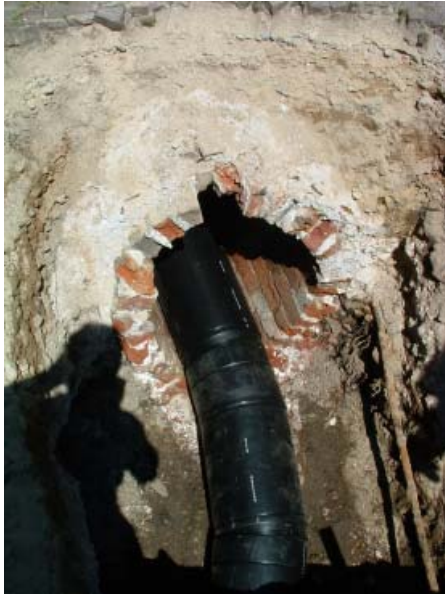
Bild 10: PE-Module im Bogenbereich,
