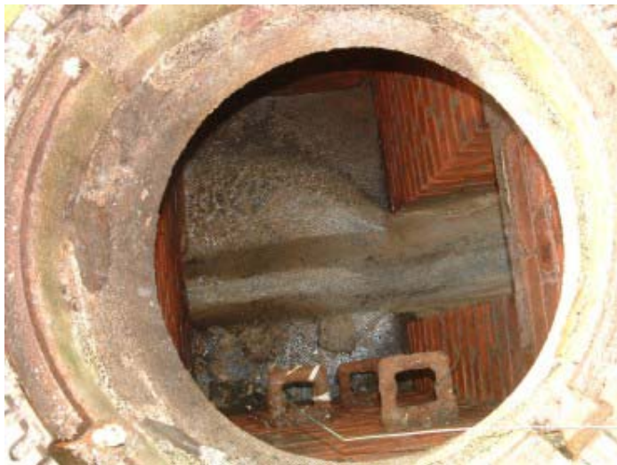
Bild 4 u. 5: Schachtbereich mit „Rutsche“
