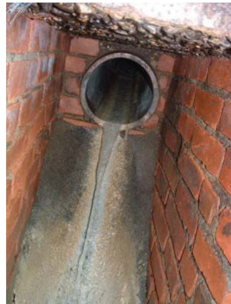
Bild 3: Kreuzende Leitung im gemauerten Ei-Profil 700/900 mm
