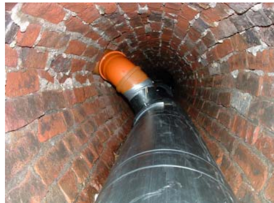
Bild 13: Anschluß des Zulaufes
