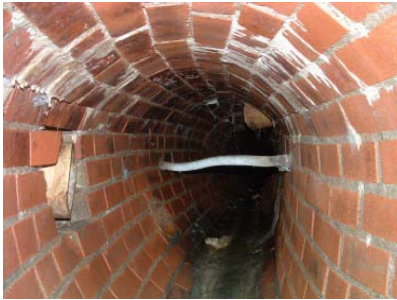
Bild 3: Kreuzende Leitung im gemauerten Ei-Profil 700/900 mm
