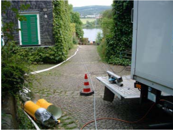
Bild 6: Sanierungsstrecke in Fließrichtung
